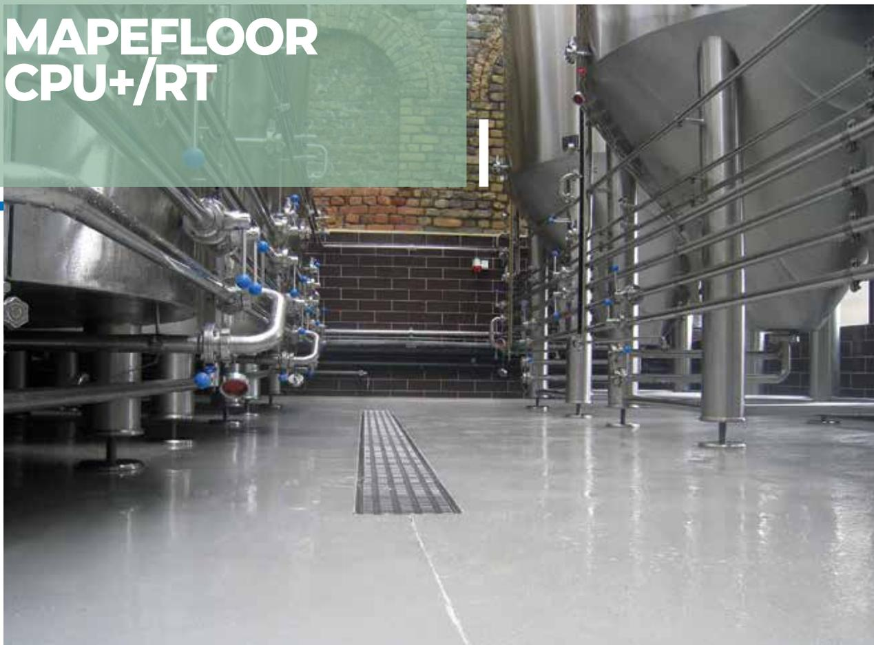
Sistema a base di formulato poliuretano-cemento, ad alta resistenza chimica, meccanica e agli shock termici, di facile applicazione, per rivestimenti antisdrucchiolo di pavimentazioni industriali in uno spessore compreso tra 6 e 9 mm.
