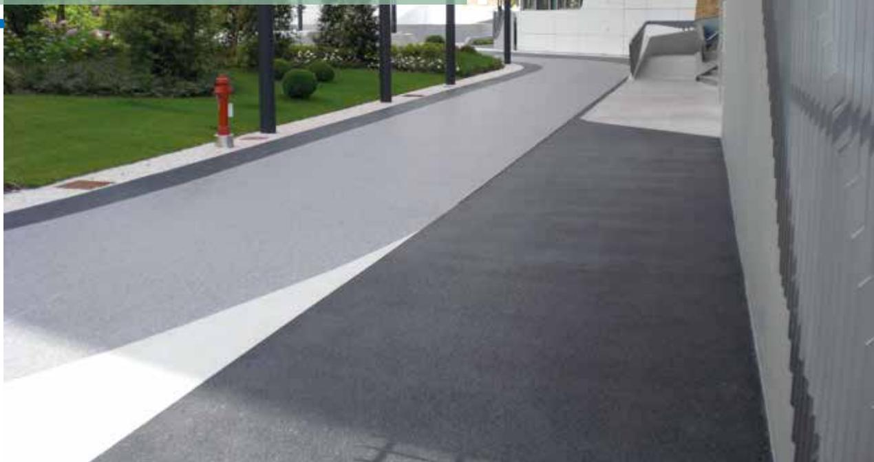
Sistema drenante a base di legante poliuretano alifatico monocomponente, da miscelare con aggregati naturali di granulometria 2-4 o 4-8 mm, per la realizzazione di pavimentazioni decorative per esterni.
