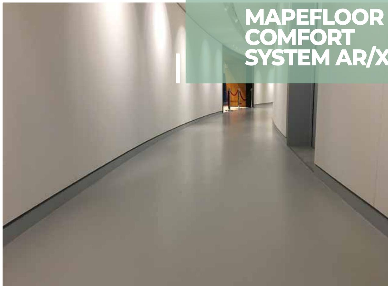
Sistema autolivellante, elastico e flessibile, UV resistente, a base di resina poliuretanica aromatica, per rivestimenti di ambienti interni, di spessore 6 mm.
