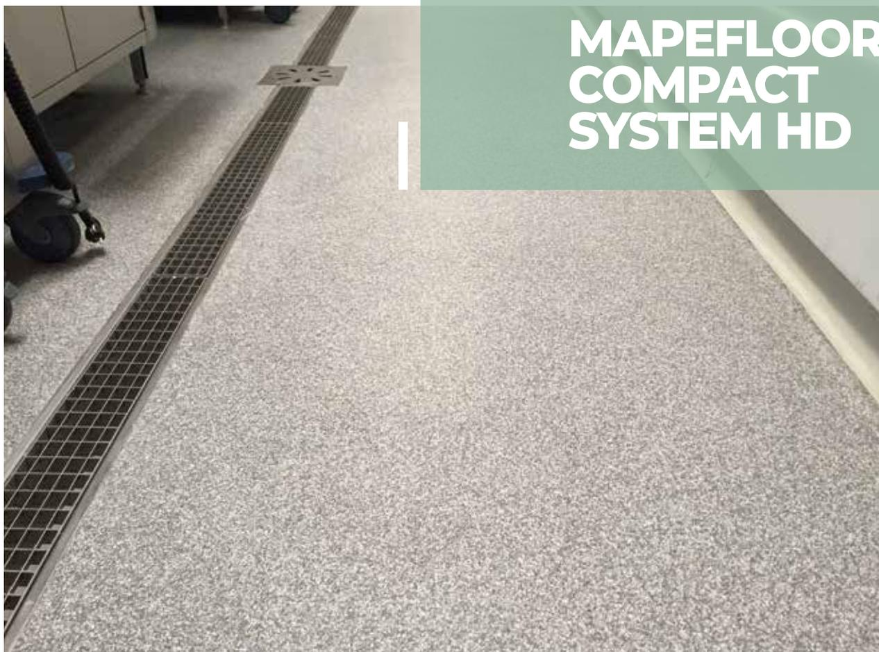
Sistema epossidico a massetto di malta resinosa a poro chiuso, di elevato valore estetico, per la realizzazione di pavimentazioni industriali e commerciali in uno spessore di 5,0-8,0 mm.
