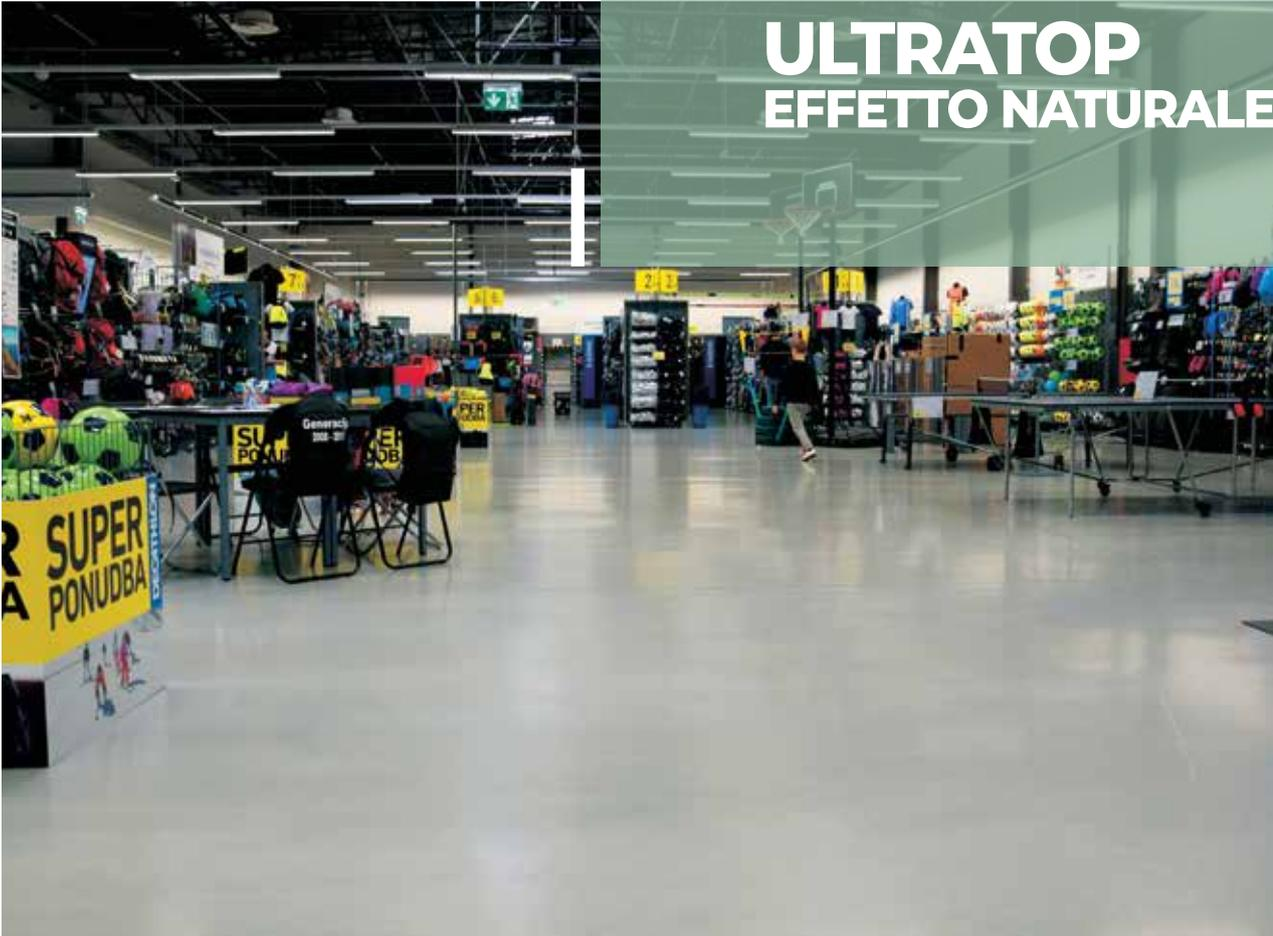
Sistema cementizio autolivellante, ad indurimento ultrarapido, per realizzare pavimentazioni resistenti all'abrasione in uno spessore compreso tra 5 e 40 mm.
