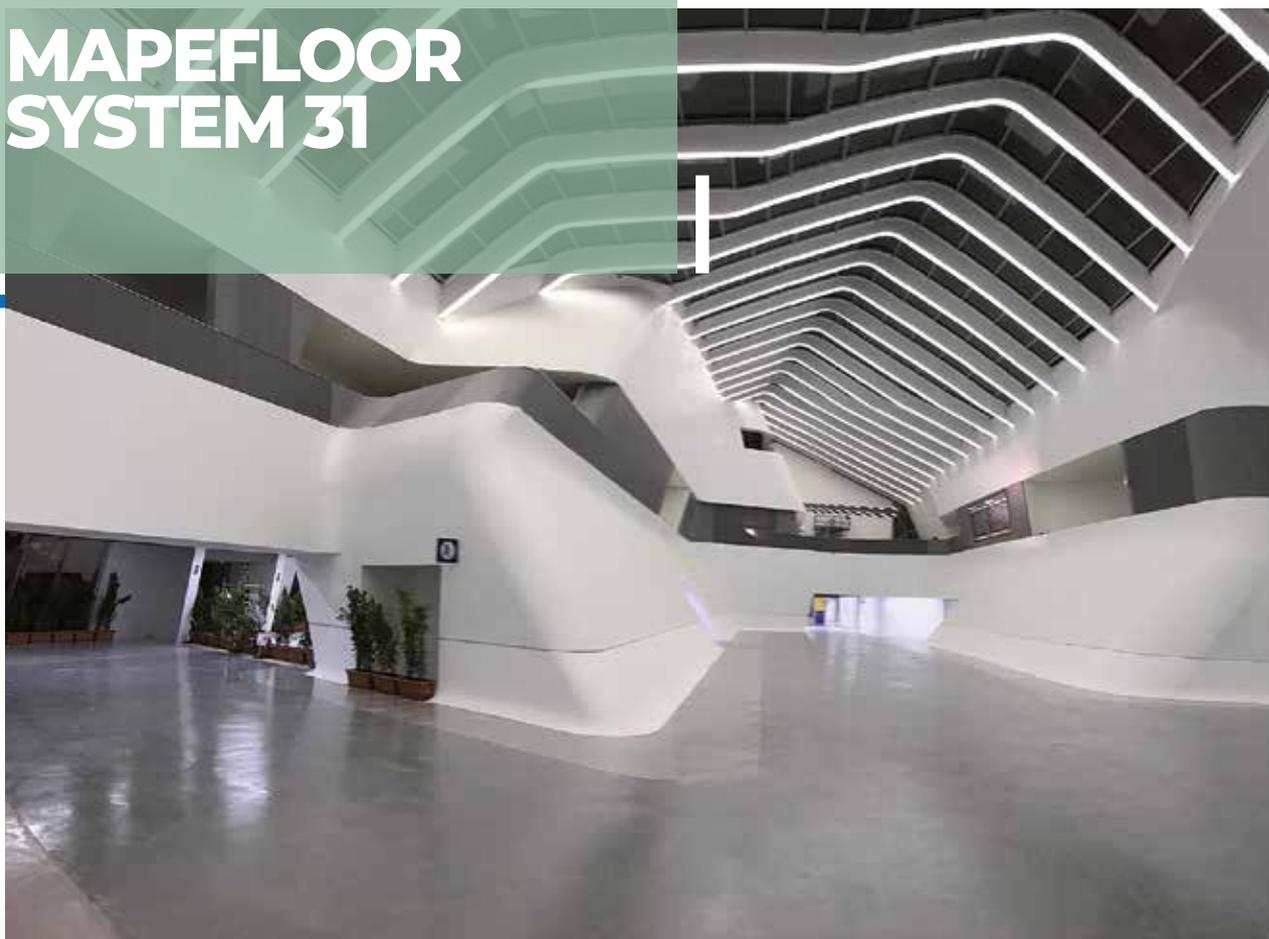
Sistema epossidico multistrato antisdrucchiolo, ad alto contenuto di solidi, per pavimentazioni industriali in uno spessore compreso tra 0,8 e 1,2 mm.
