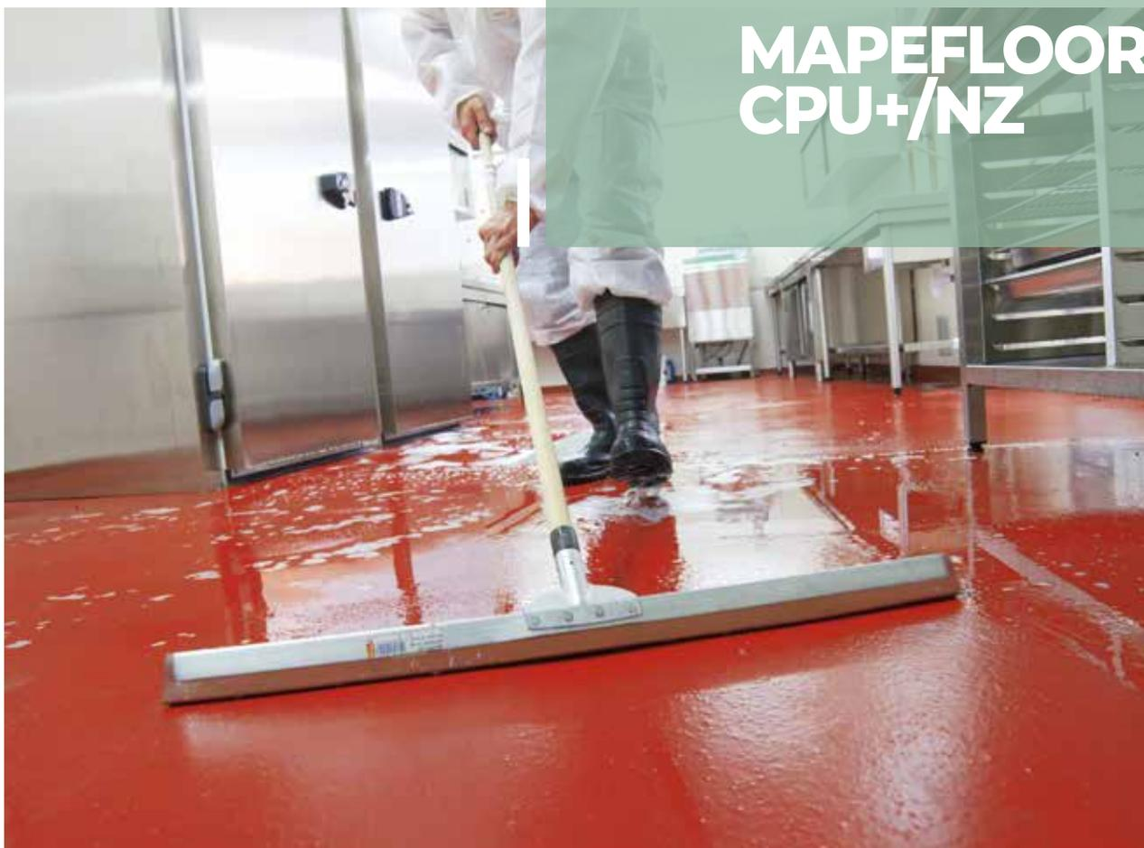
Sistema a base di formulato poliuretano-cemento, ad alta resistenza chimica, meccanica e agli shock termici, di facile applicazione, per rivestimenti antisdrucchiolo di pavimentazioni industriali in uno spessore compreso tra 4 e 6 mm.
