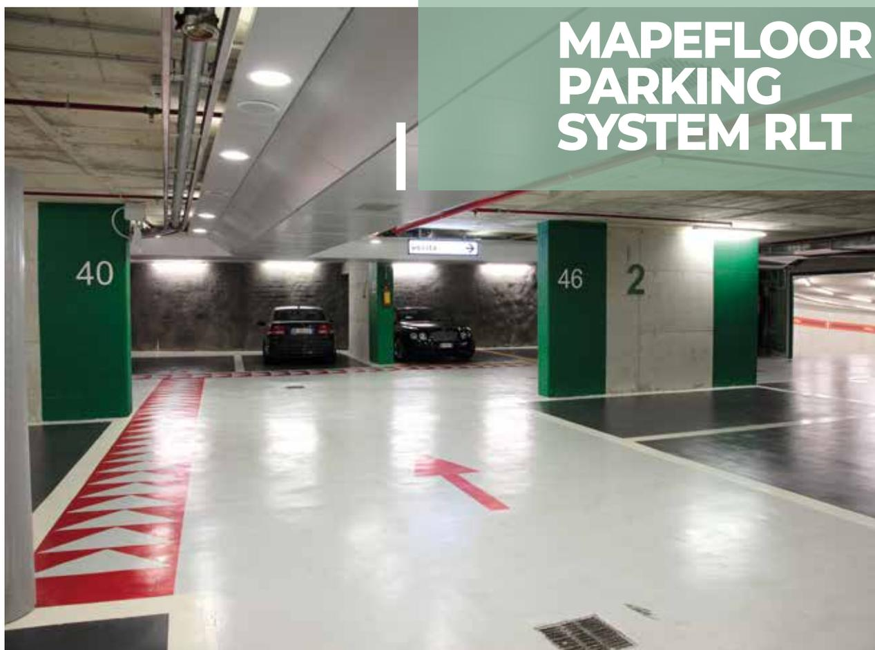
Sistema epossidico multistrato continuo, per aree pedonali o carrabili soggette a traffico leggero in accordo alle Guideline of the German Committee on Reinforced Concrete OS 8 e ai sistemi di protezione delle superfici in calcestruzzo secondo EN 1504-2. Spessore 0,8 -1,2 mm.
