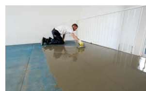
Soluzione di livellamento per un supporto perfettamente uniforme e liscio. Pagina 54
