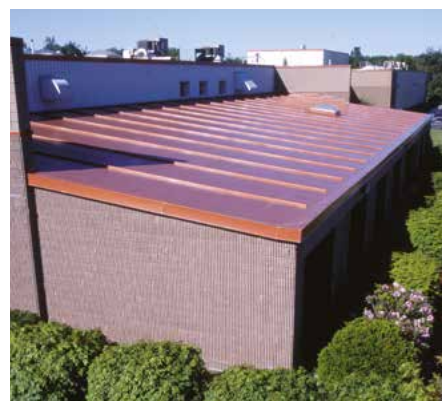
Coperture ad elevata valenza estetica
