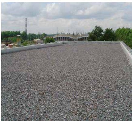
Coperture zavorrate ghiaia
