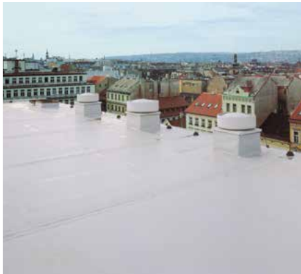
Coperture a vista
