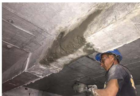
Riparazione del calcestruzzo, Pag. 28
