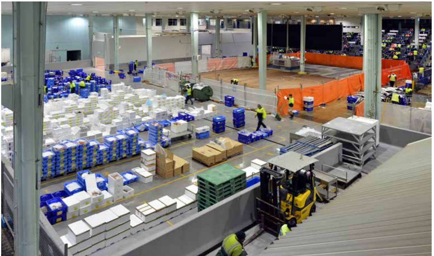
Le operazioni continuarono durante i lavori di pavimentazione.
